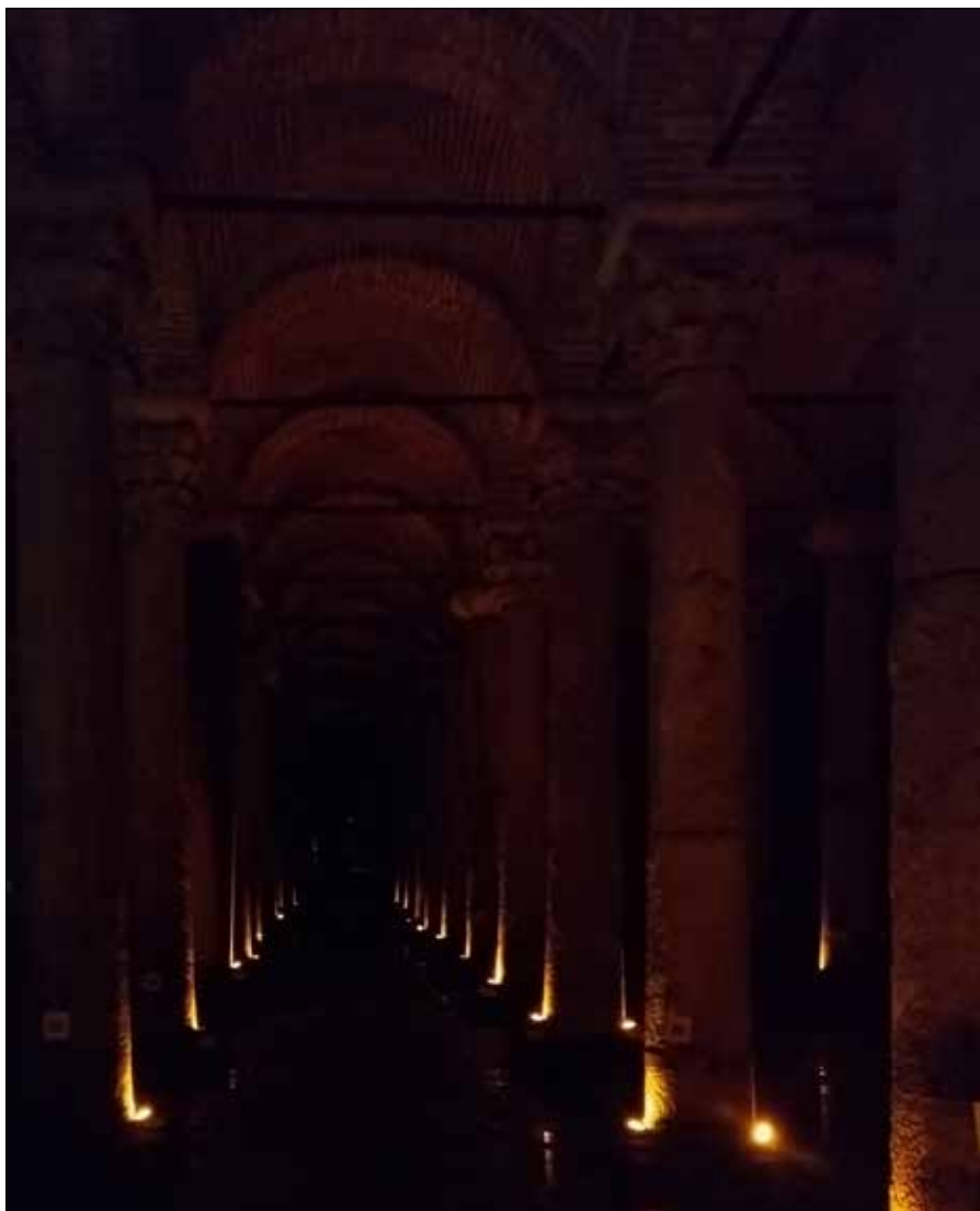
Figura 176 Interior da cisterna. Construída pelo imperador Justiniano (527-565), possui 70m de largura x 140m de comprimento; 336 colunas com altura de 9m separadas por espaços de 4,80m, com capitéis estilos dórico e coríntio. Possui área de 9.800m 2 e estima-se suportar 100.000 toneladas de água.
