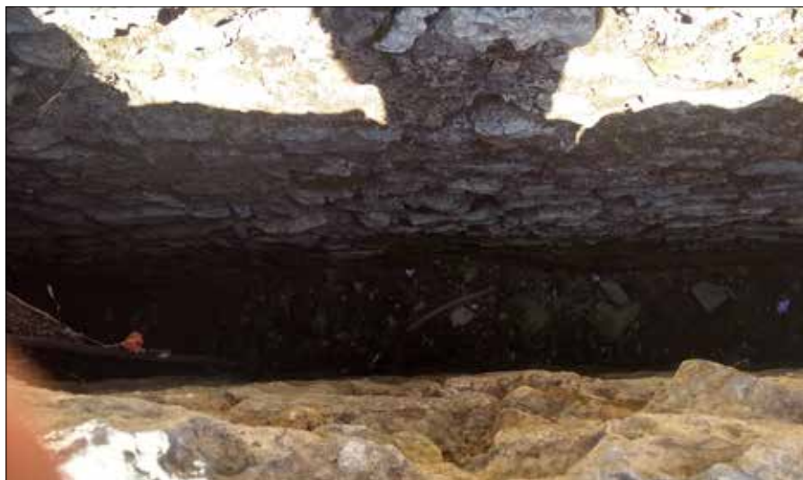
Figura. 82 Fosso com água corrente sob as latrinas, dissipando dejetos e odores.
